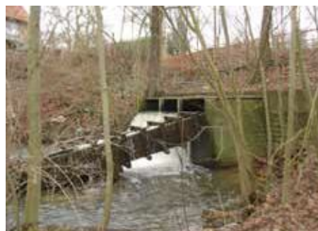
Fisketrappen umiddelbart inden nedrivning.
