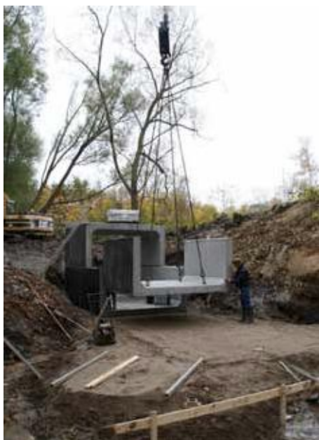
Ny tunnelbro (28. oktober 2009).
