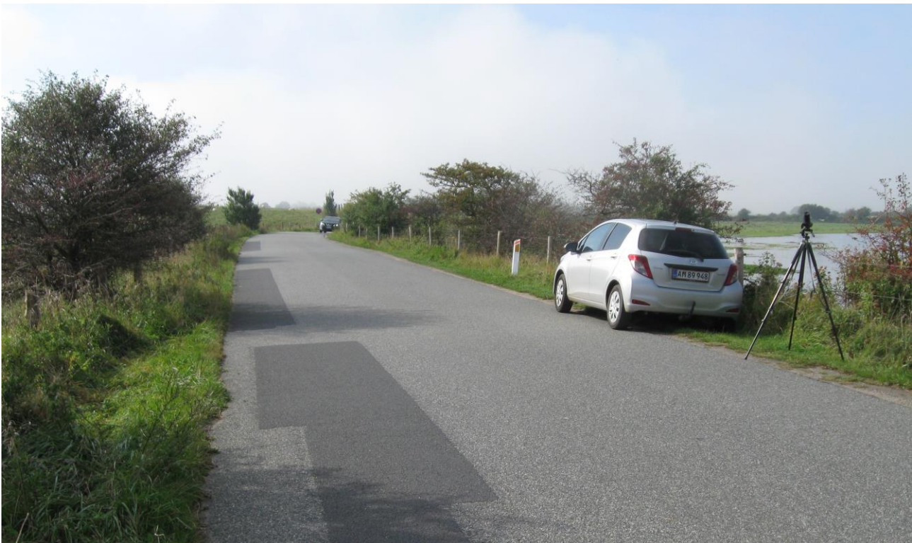
Fig. 4. Kig mod sydvest. Rabattens nuværende bredde ved den hvide bil er ca. 2 m fra asfaltkant til hegn.
